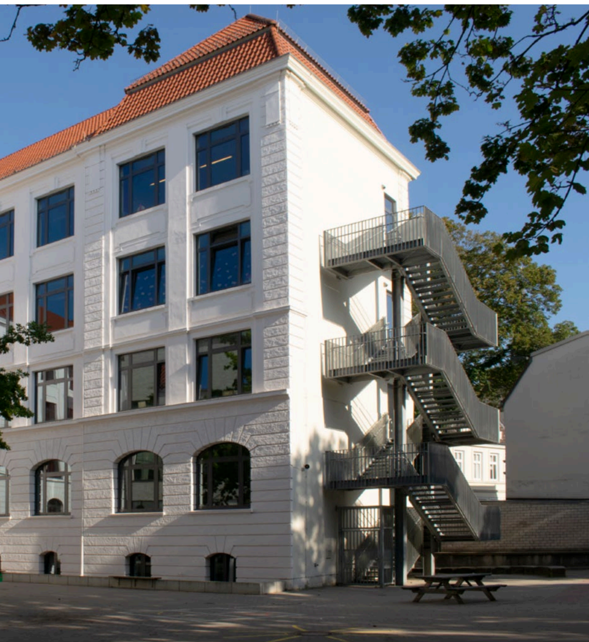
Ein zusätzliches Fluchttreppenhaus erleichtert bei älteren Gebäuden eine neue Gestaltung und Nutzung der Flure im Inneren. Schule Kielortallee, Hamburg
