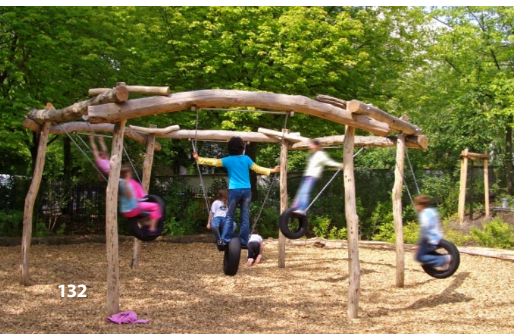
Bewegungsinstallation aus Holz, nicht aus Metall. Ein natürlicher Bodenbelag aus Holzschnitzeln nimmt das Regenwasser auf und mindert die Verletzungsgefahr der Kinder bei Stürzen.
