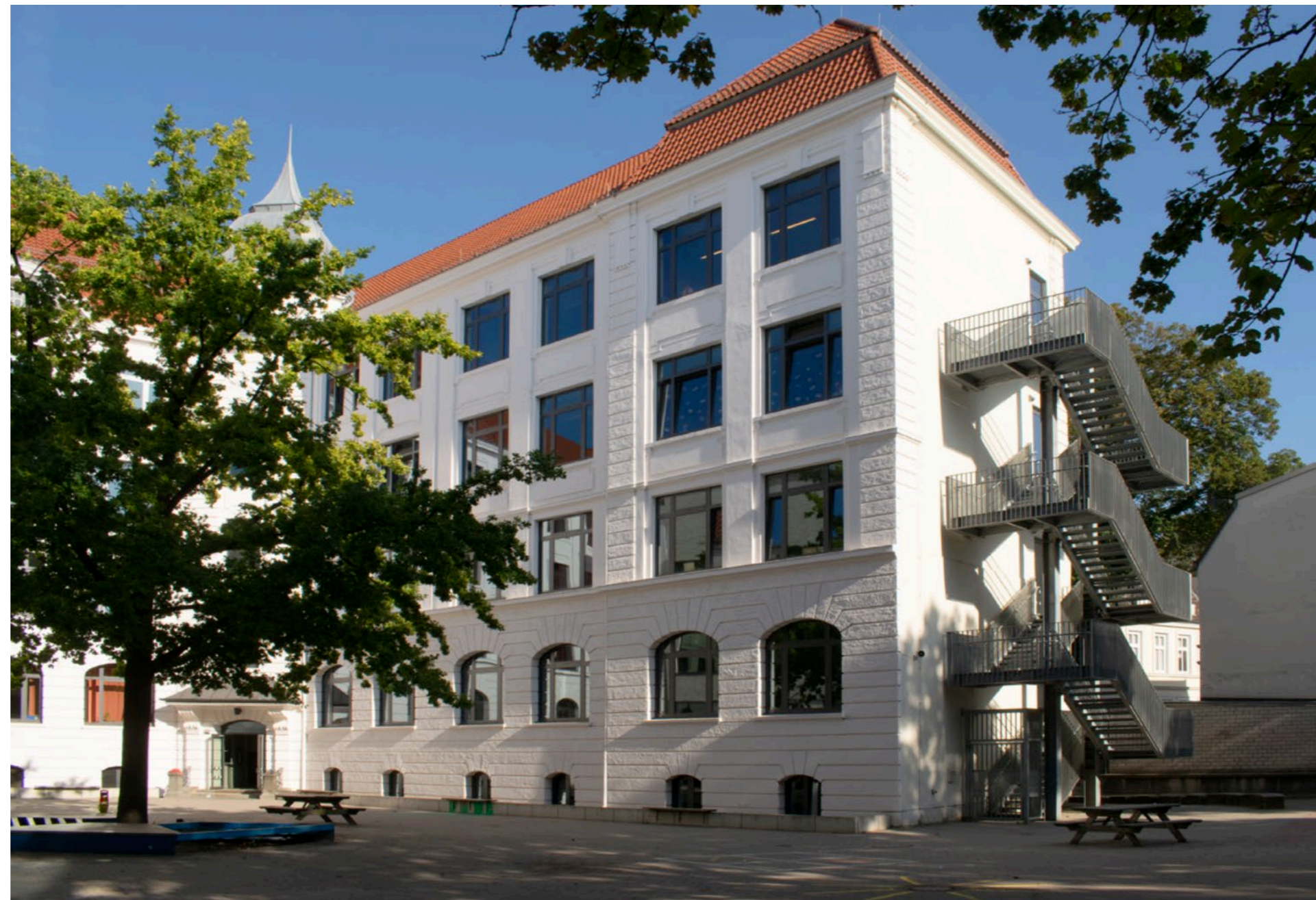
Ein zusätzliches Fluchttreppenhaus erleichtert bei älteren Gebäuden eine neue Gestaltung und Nutzung der Flure im Inneren. Schule Kielortallee, Hamburg
